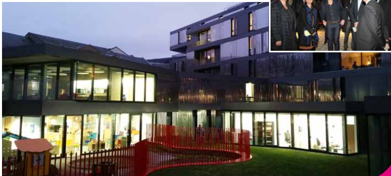
Un bâtiment aux lignes contemporaines, parfaitement intégré au quartier.
