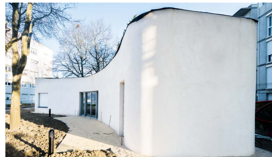
La maison Yhnova (ici en chantier), dont les murs ont été construits par un robot imprimante 3D en seulement 54h, sera attribuée d'ici cet été à une famille sélectionnée par la Commission d'Attribution de Logement de NMH, selon les critères habituels du logement social.
